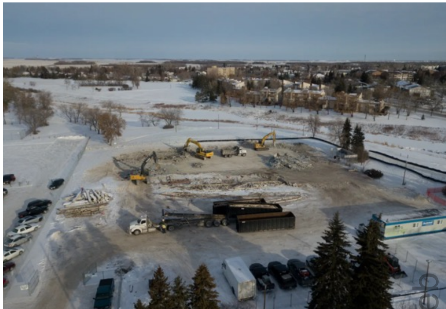
Démolition de l'aréna Vimy en vue de la construction du centre de traitement, déc. 2019. Photo : Storm The Castle Media
